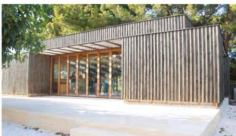
→ Une **salle polyvalente** à Coudoux : 1<sup>er</sup> bâtiment public utilisant du pin d'Alep en structure et selon le DTU 31.2 pour les murs.
