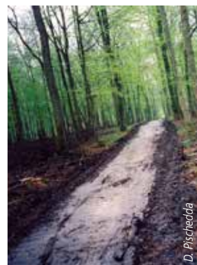
Après « remise en état » : les ornières ont seulement été rebouchées par la lame de l'engin
